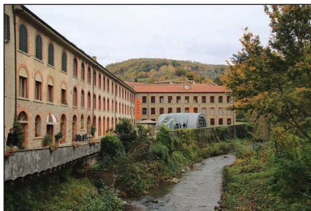
Fig. 1 - Museo dell'Arte della Lana), Stia-Arezzo Italy. The entrance of the museum, the Edificio dell'Orologio, on background, with the old restored turbine, in the foreground the Staggia river and the logo of the museum in the bottom (Museo dell'Arte della Lana, Stia).
