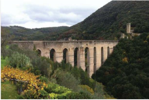
Fig. 5. Ponte delle Torri, Spoleto.
